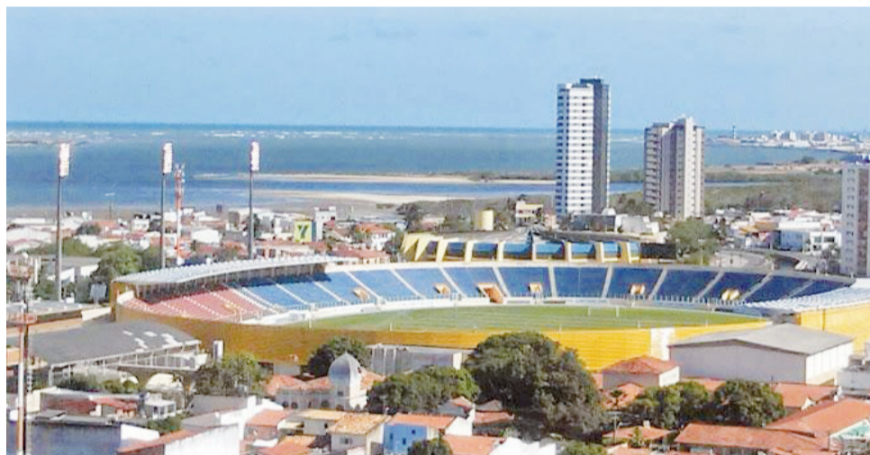
Como medida de prevenção, a Arena Batistão passa por vistoria técnica da Defesa Civil
