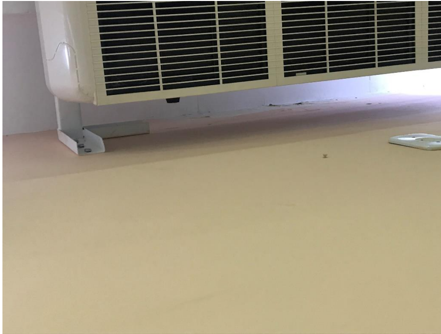
Foto 9 – Trincas no forro de gesso no auditório.
