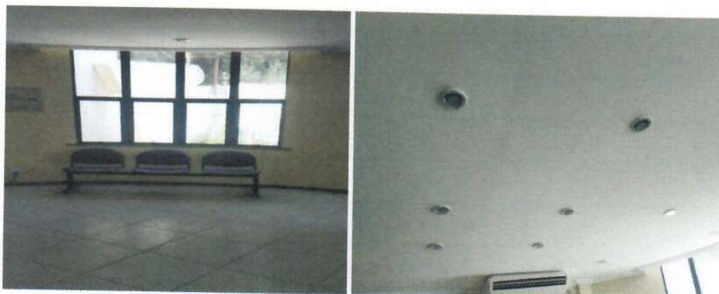
Item 02.003 – Ficha 3 – Secretaria Conclusão da pintura nas paredes.
