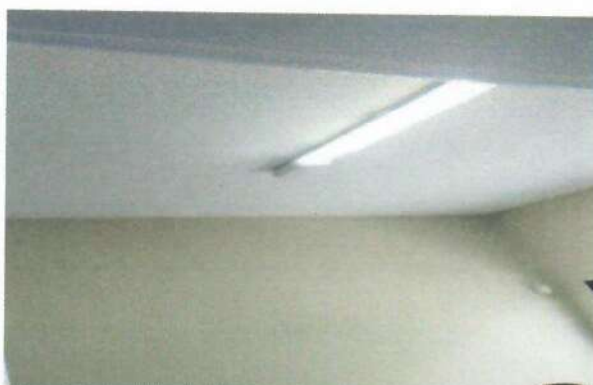
Item 02.005 – Ficha 5 – Corredor Serviços de pintura nas paredes e teto
