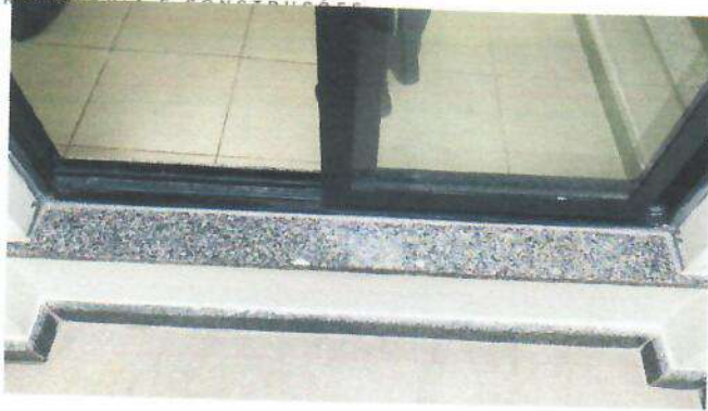
Item 02.009 – Ficha 9 – Hall auditório
